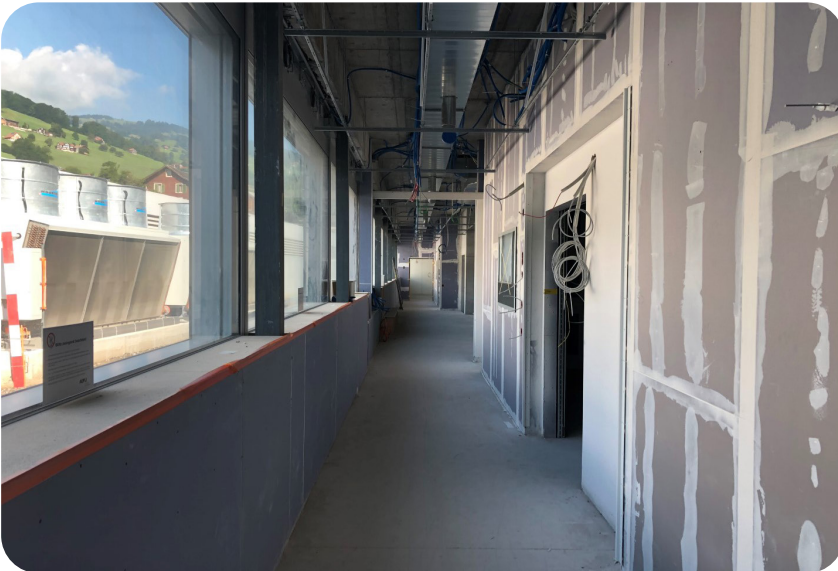
Rohbau Gang zu OP-Räumen
